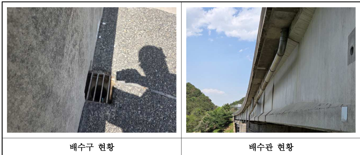
【사진 7.3.22】 배수시설 전경
