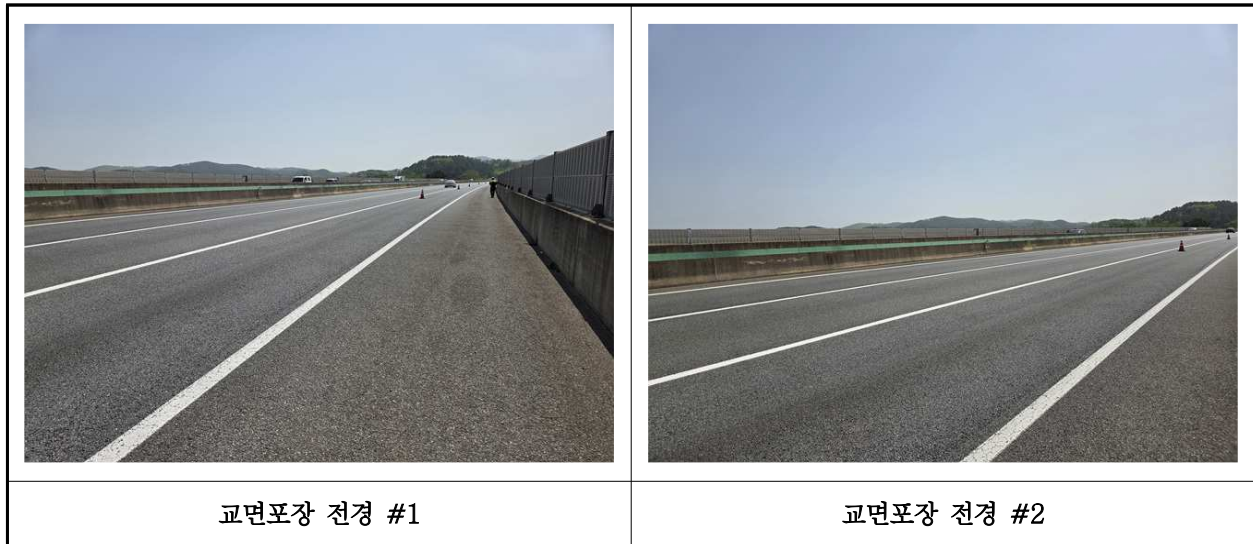
【사진 7.3.20】 교면포장 전경
