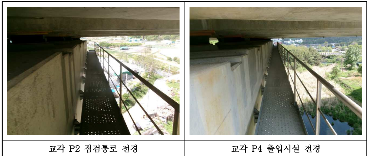
【사진 7.3.26】 교량 점검시설 전경
