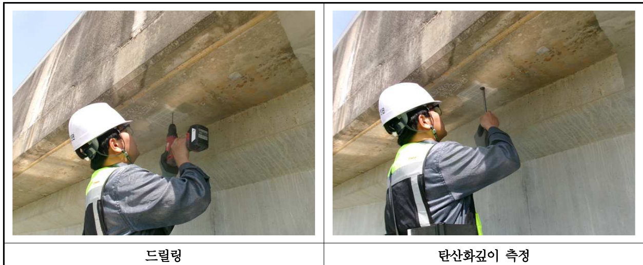
【사진 7.4.3】 탄산화 깊이 측정 현장사진
