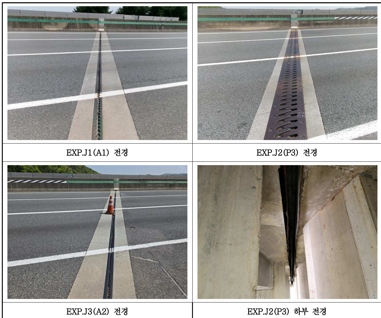
【사진 7.3.17】 신축이음장치 전경
