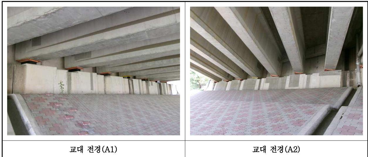
【사진 7.3.8】 교대 전경
