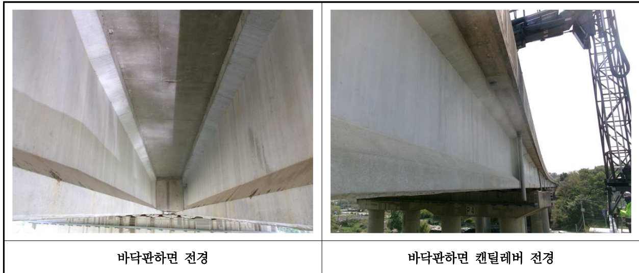
【사진 7.3.2】 바닥판하면 전경
