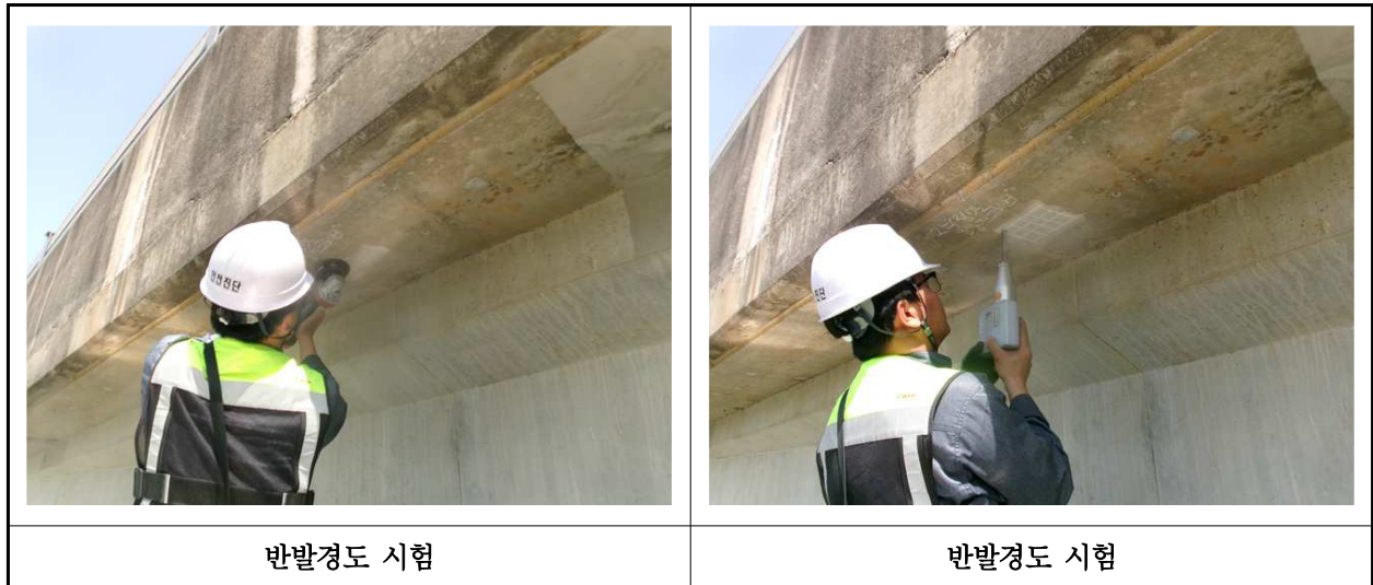
【사진 7.4.2】 반발경도시험 현장사진
