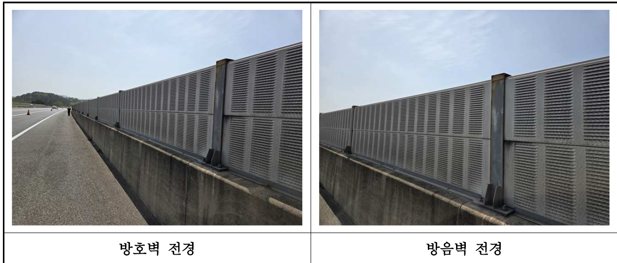
【사진 7.3.24】 방호벽 및 중분대 전경
