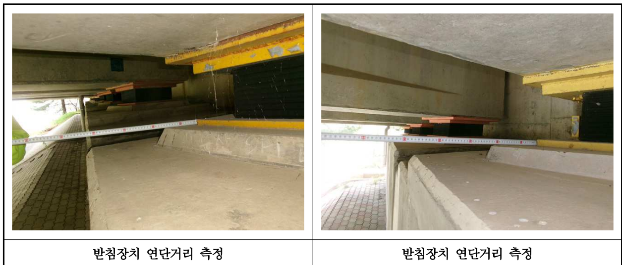
【사진 7.3.15】 교량받침장치 연단거리측정
