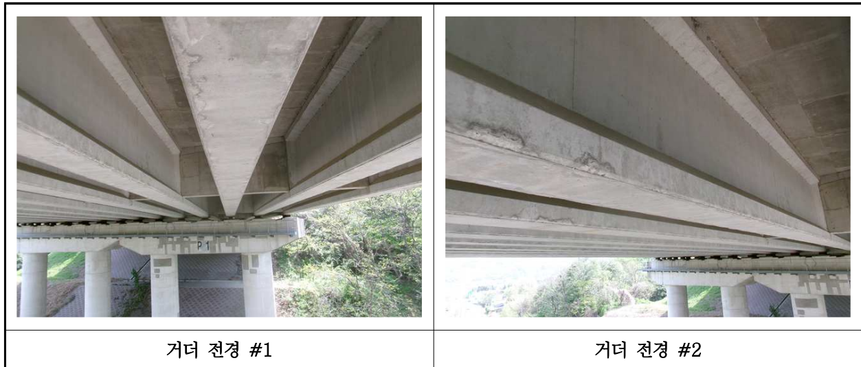
【사진 7.3.4】 거더 전경
