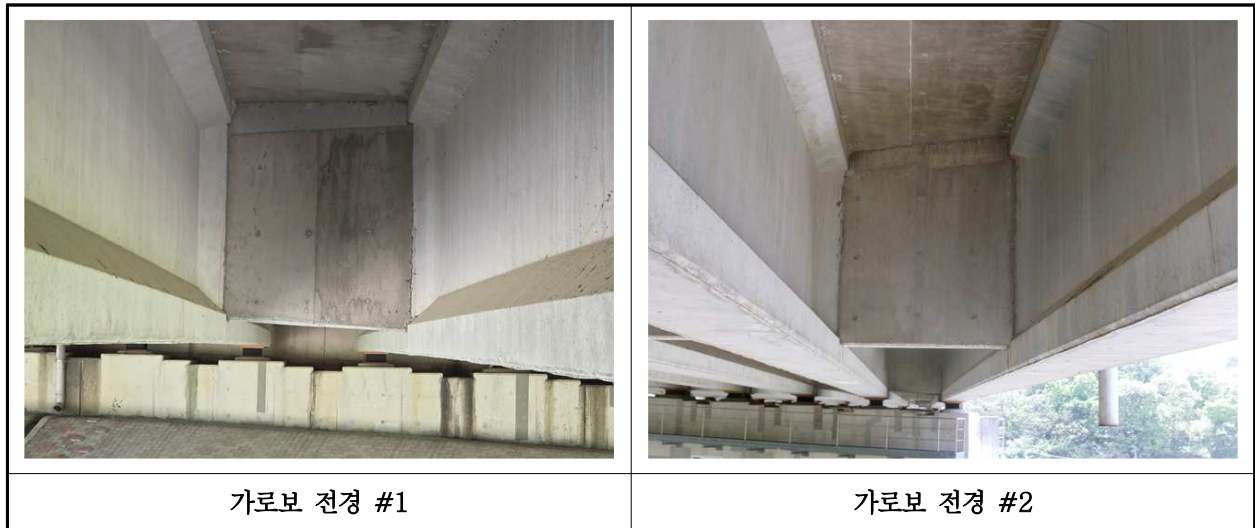
【사진 7.3.6】 가로보 전경
